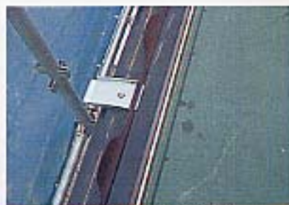
⑤ 軒先面戸の取り付け
