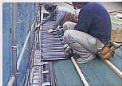
⑥ 屋根本体の取り付け (1)
