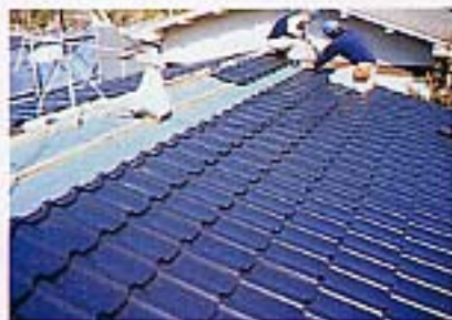
⑧ 屋根本体の取り付け (3)
