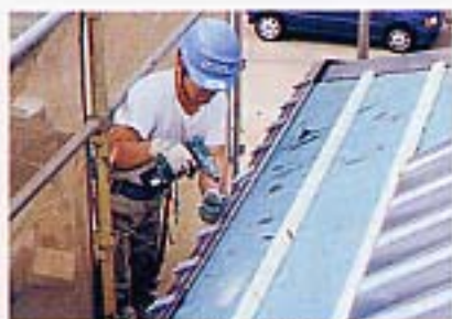
④ 軒先金具の取り付け
