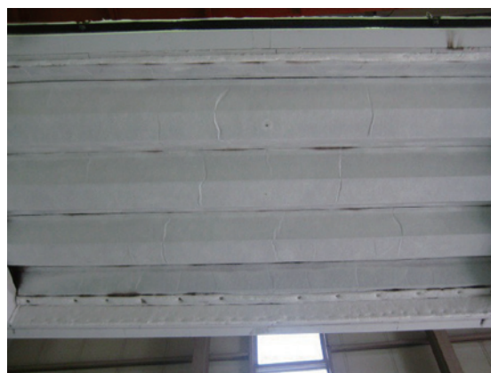
図7 試験終了後の試験体の状況(加熱面)
