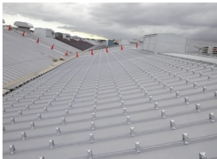
瓦棒ぶき屋根の改修
