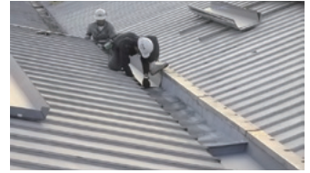
谷どいの改修
